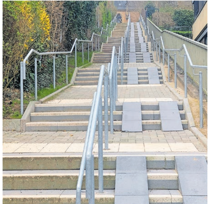
Die neugestaltete Treppenanlage in der Klosterstraße in Dudweiler. Foto: LHS
